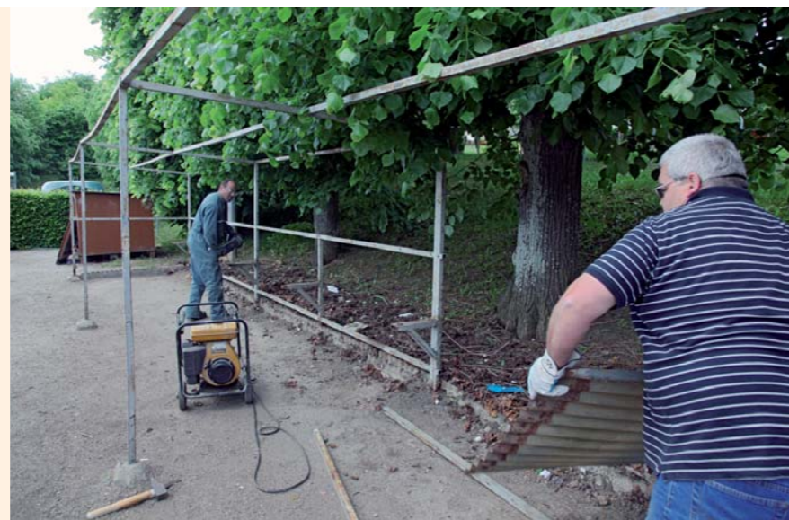
Le chantier de la place Albert Huille
