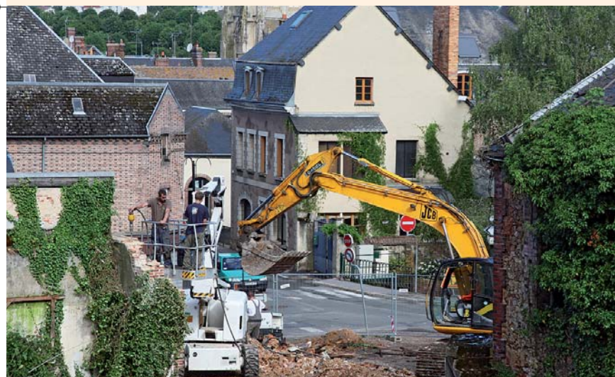
Construction de 15 logements en centre ville, face à la poste
